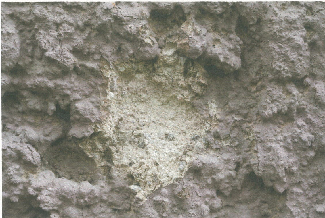
Fot. 16. Odkrywka nr 1 na cokole bocznej ściany przybudówki w północno-zachodniej części budynku. Warstwa malarska w kolorze fioletowym jest późniejsza, położono ją w celu ukrycia ubytków i napraw, być może w 1994 roku podczas prac związanych z budową podjazdów. Pod spodem widoczna warstwa różowa, pokrywająca całą elewację budynku.
