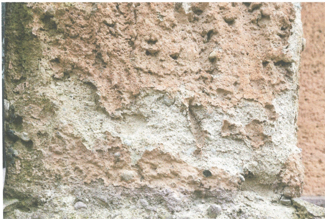
Fot. 11, 12. Odkrywka nr 1 na narożniku przybudówki w północno-zachodniej części budynku. Fragmenty na ścianie południowo-zachodniej. Jedyną powłoką malarską jest warstwa w kolorze różowym. Tynk w tej części budynku (w sąsiedztwie północnego narożnika) jest silnie osłabiony, miejscami spiaszczony.
