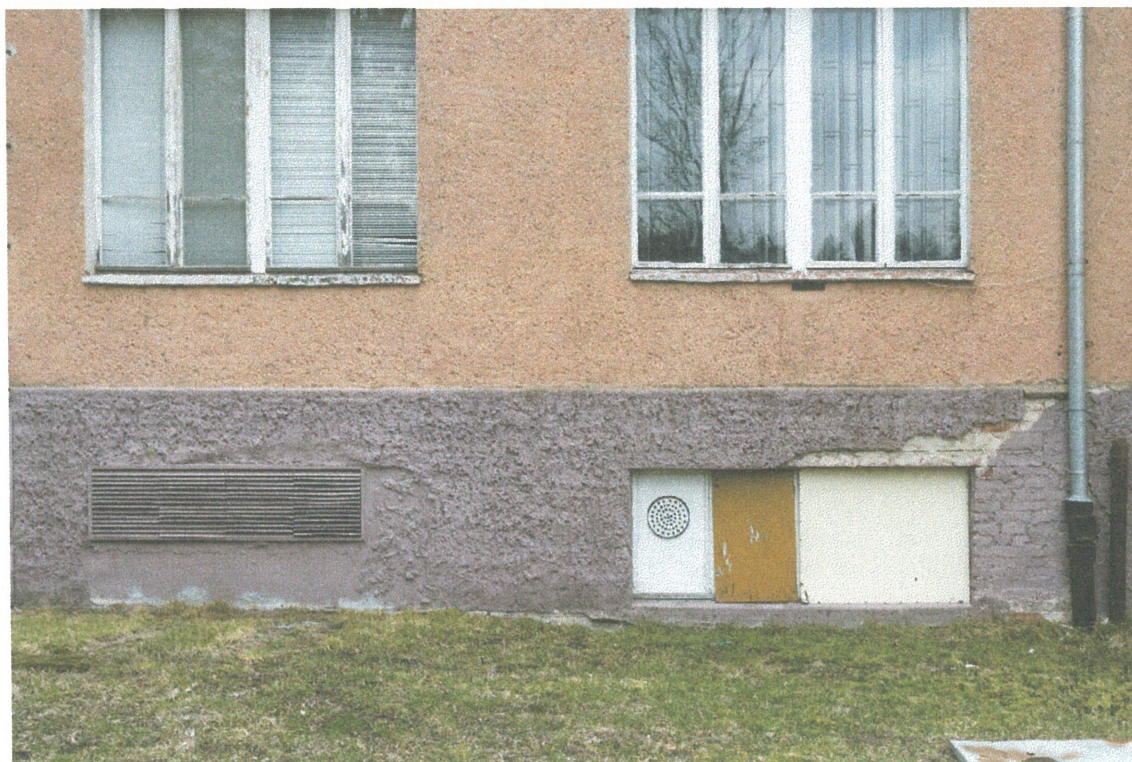
ot. 32. Fragment cokołu w elewacji południowo-zachodniej, po lewej stronie ryzalitu. Widoczne naprawy oraz zniszczenia zamaskowane powłoką malarską w kolorze fioletowym.
