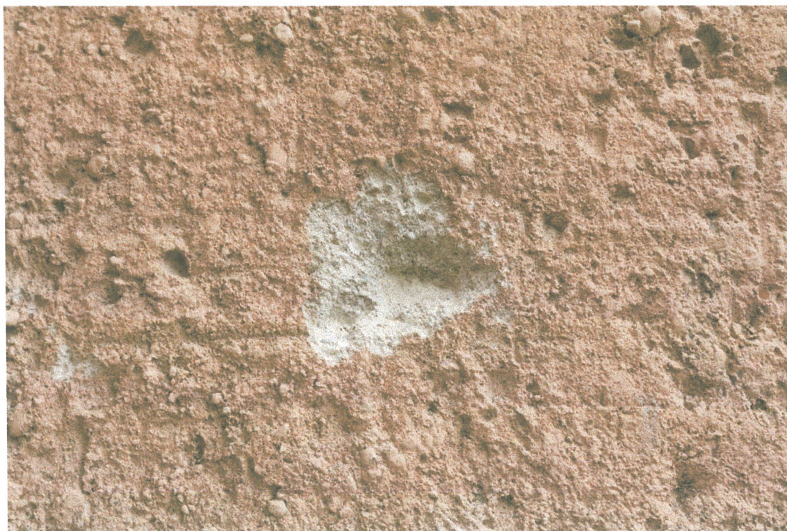
Fot. 17. Odkrywka nr 2 na elewacji południowo-zachodniej, w sąsiedztwie narożnej przybudówki. Na ścianach głównego korpusu budynku tynki są zachowane lepiej niż na przybudówce. Mimo podobnej, gruboziarnistej struktury mają inaczej zatartą powierzchnię.
