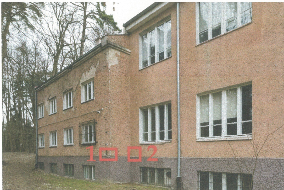
Fot. 10. Elewacja południowo-zachodnia (od strony Jeziora Mumel), narożnik południowy. Widoczne różnice w fakturze cyklinowanych tynków na elewacji głównej bryły budynku oraz na ścianach narożnej przybudówki. Jedynie na cokole tynki są opracowane podobnie. Na zdjęciu zaznaczono lokalizację odkrywek.
