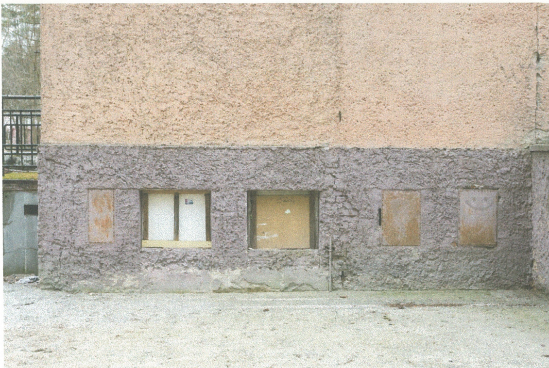
Fot. 31. Fragment cokołu w elewacji szczytowej, południowo-wschodniej, widoczne naprawy oraz zniszczenia zamaskowane powłoką malarską w kolorze fioletowym.
